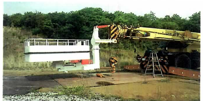
SS-300 50Tラフター取付
