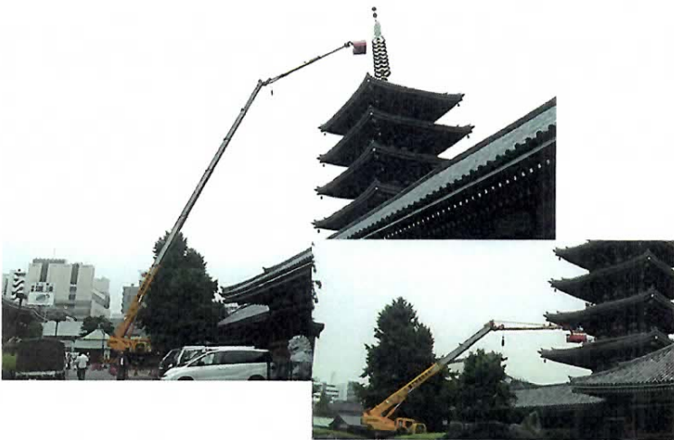
五重塔メンテナンス 50m作業 60Tラフター
