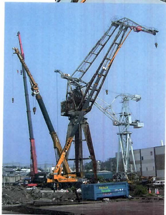
造船所クレーン解体 50m作業 50Tラフター
