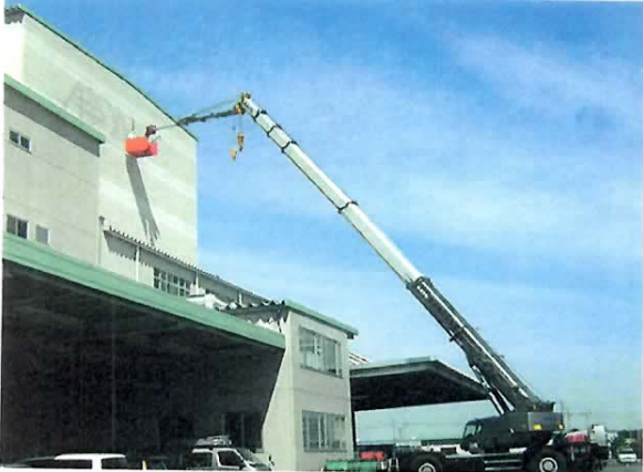
倉庫看板作業 半径30m 50Tラフター
