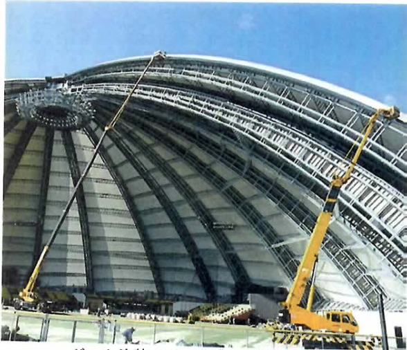
ドーム塗装 55m作業 50Tラフター
